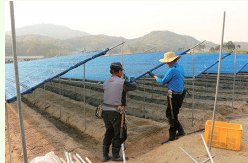
해가림 시설 설치
